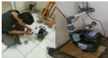
Gambar 9. Pompa Shimizu PS-135 E dan Perangkaiannya
