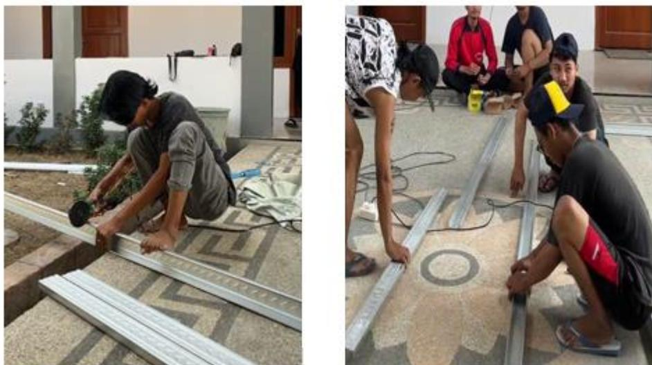
**Gambar 2.** Proses pemotongan galvalum untuk pembuatan Greenhouse
