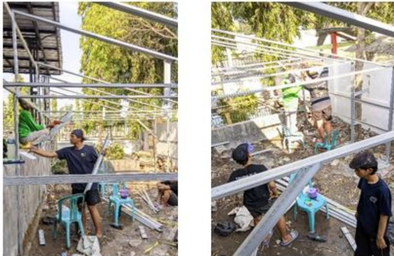
**Gambar 3.** Proses pemasangan galvalum untuk pembuatan Greenhouse
